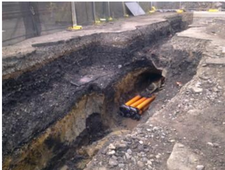
Conduit Route Construction
